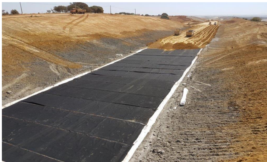
Figure 7. Approvisionnement, étalage et réglage des matériaux de remblaiement après pose du géocomposite
