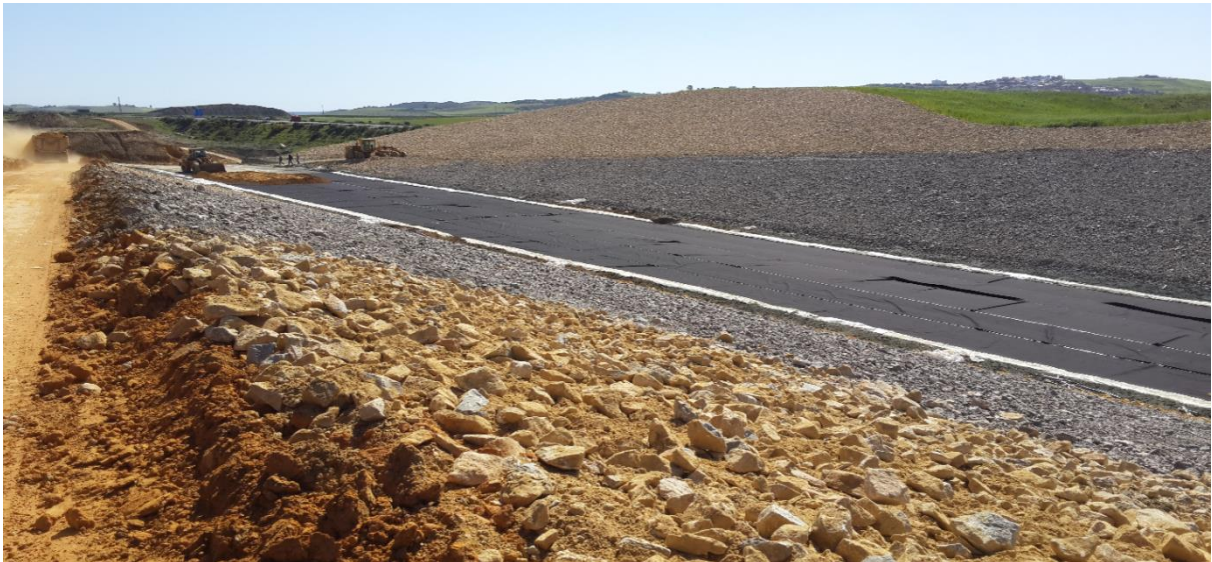
Figure 8. Mise en place des lés de géosynthétique
